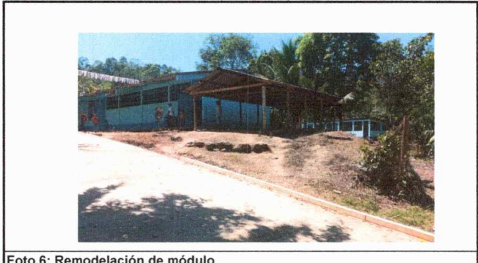
Foto 6: Remodelación de módulo
